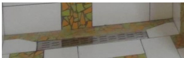
Photographie 4 - ReQup®-Floor sol carrelé
